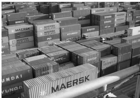
그림 3. 조명탑에서 본 필드: YT에 설치된 태그와 조명탑에 설치된 리더는 철제 컨테이너가 높이 적재된 경우 LOS통신이 거의 불가능하며 이는 거리 측정에 큰 오차를 포함할 수 있다
