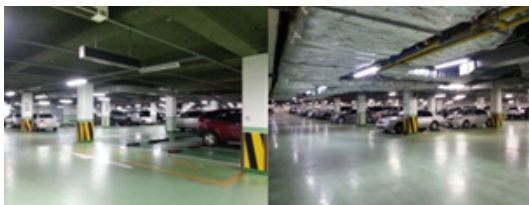
그림 11. 실험환경 2: 지하 주차장 Fig. 11. Experimental environment 2: Parking Lot
