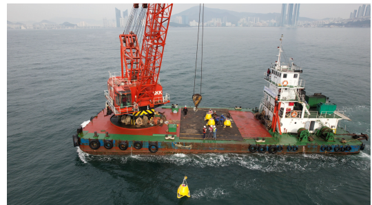
그림 15. 크레인을 사용한 부이,수중 기지국,센서노드 설치 작업 Fig. 15. Buoy, underwater base station, and sensor node installation work using a crane
