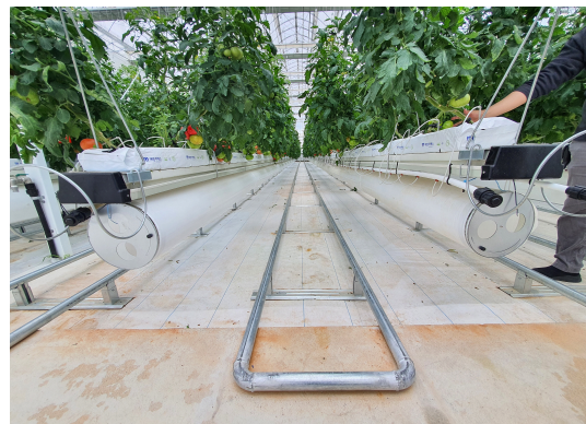
그림 4. 시설원예의 베드 및 파이프 Fig. 4. Bed and pipe of green house
