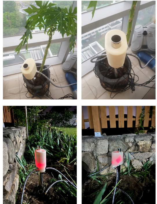
그림 8. 관개 제어기 설치 Fig. 8. Installation of Irrigation Controller in Outdoor
